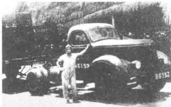
◎即将起运的拖车，车旁站立者为机工林春才。
